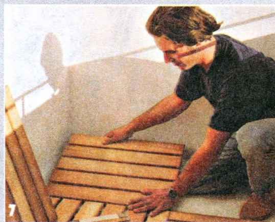
Если обрезка замыкающих щитов сделана точно по разметке, они легко встанут на свое место без чрезмерных зазоров.
