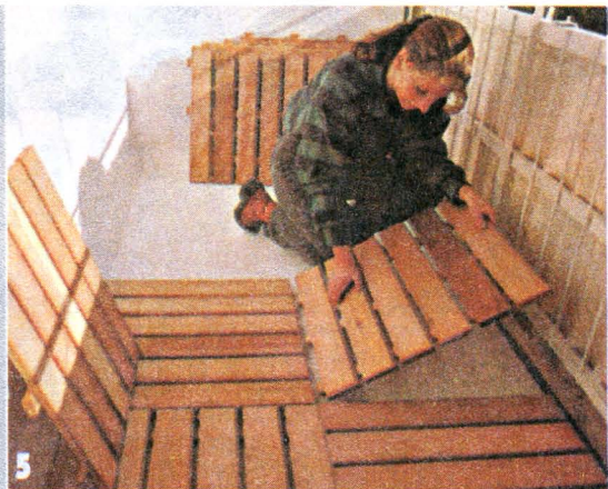
Изоляция от холодного бетонного пола, простота укладки, внешняя привлекательность – вот основные достоинства деревянного щитового пола. Эффективный дренаж обеспечивают щели между досками щитов и зазоры между щитами.
